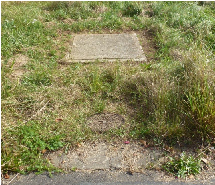
Schacht und Unterflurhydrant Bestandswasserleitung auf Vorhabengrundstück 8
